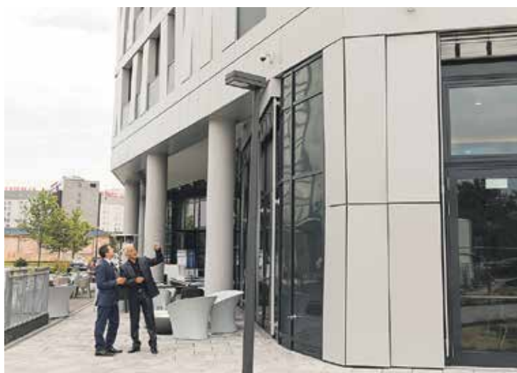
Im Außenbereich sind eneo Callisto IP-Domes im Einsatz.
